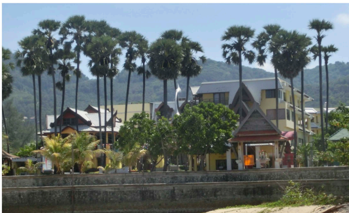
写真29 プーケットの海岸沿いのリゾートホテル
